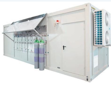
Экстрактивные газоанализаторы размещаются внутри помещения. Газ доставляется к ним по обогреваемой до  $180$  °C пробоотборной линии с использованием зонда с пылевым фильтром и насоса.
